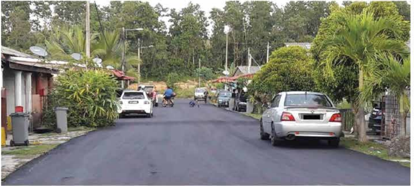
Kerja-kerja penurapan jalan di taman perumahan
