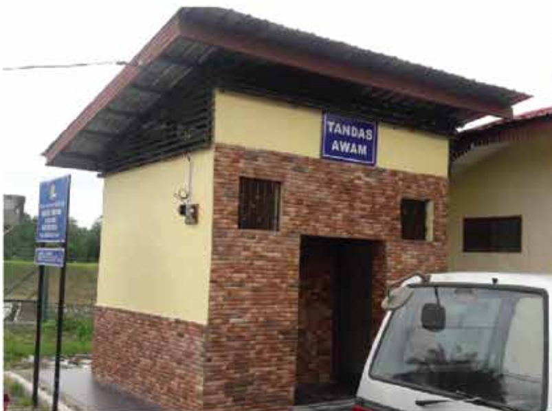
Kerja-kerja baik pulih tandas awam
