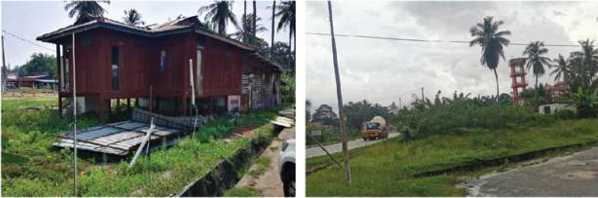
Bangunan usang yang sebelum dan selepas dirobohkan
