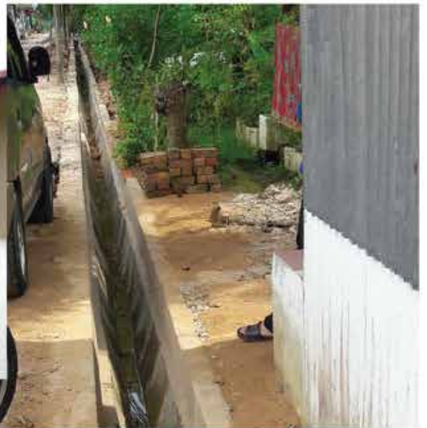
Kerja-kerja baik pulih longkang
